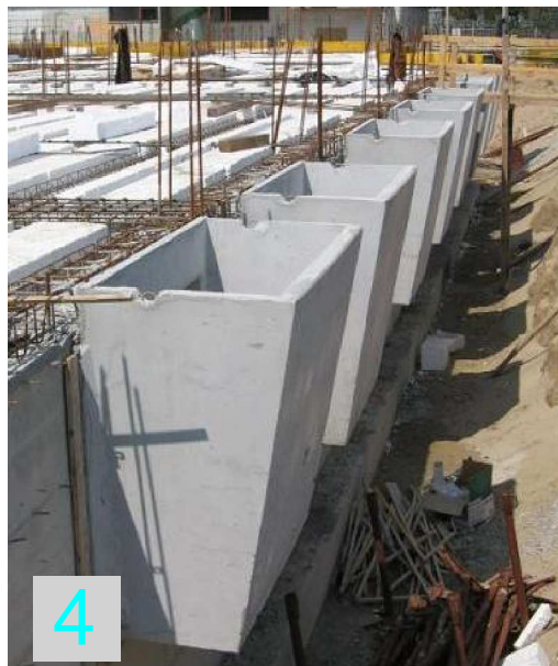
4 Getto integrativo con cls molto fluido; la Bocca di Lupo è fissata alla parete prima del getto del solaio.
